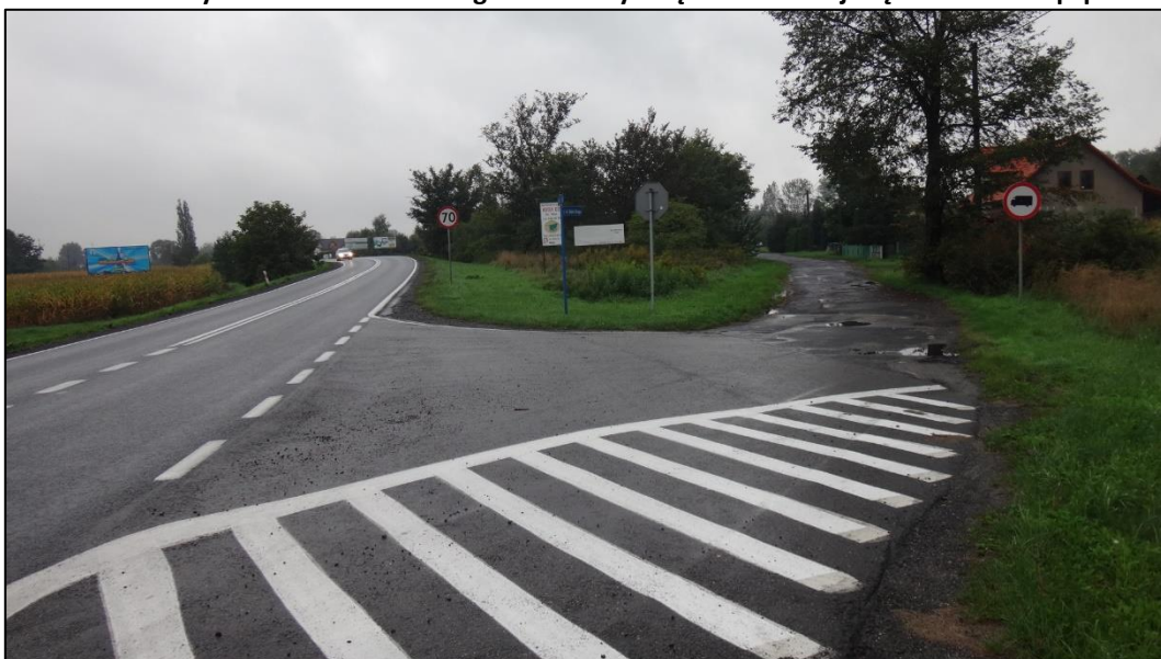
Fot. 9. Skrzyżowanie ul. Stara Droga z ul. Fabryczną w środkowej części obszaru mpzp.
