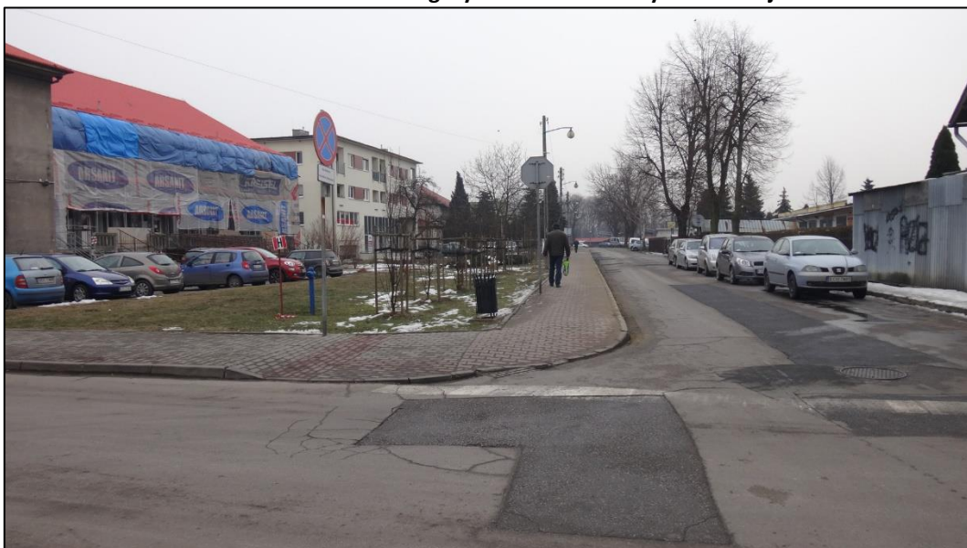
Fot. 2. Ulica Żwirki i Wigury – widok od strony zachodniej.
