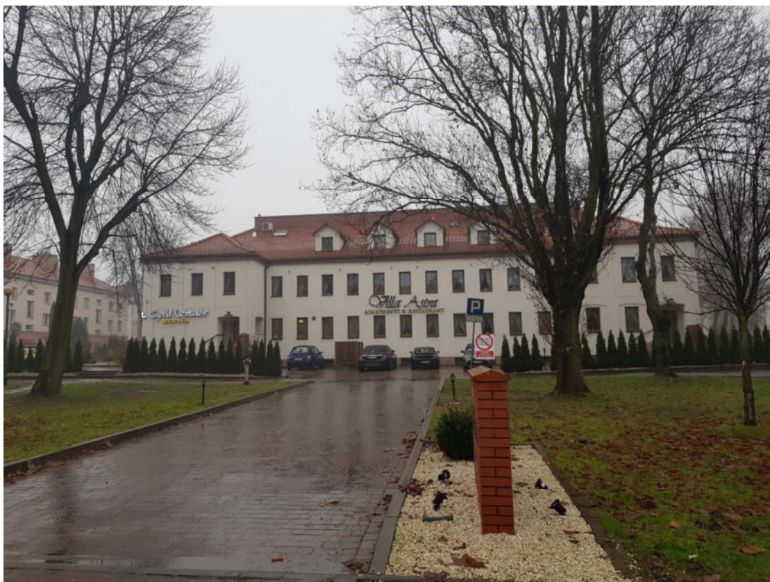
Fot. 1. Istniejący budynek hotelu – widok z ul. Olszewskiego.
