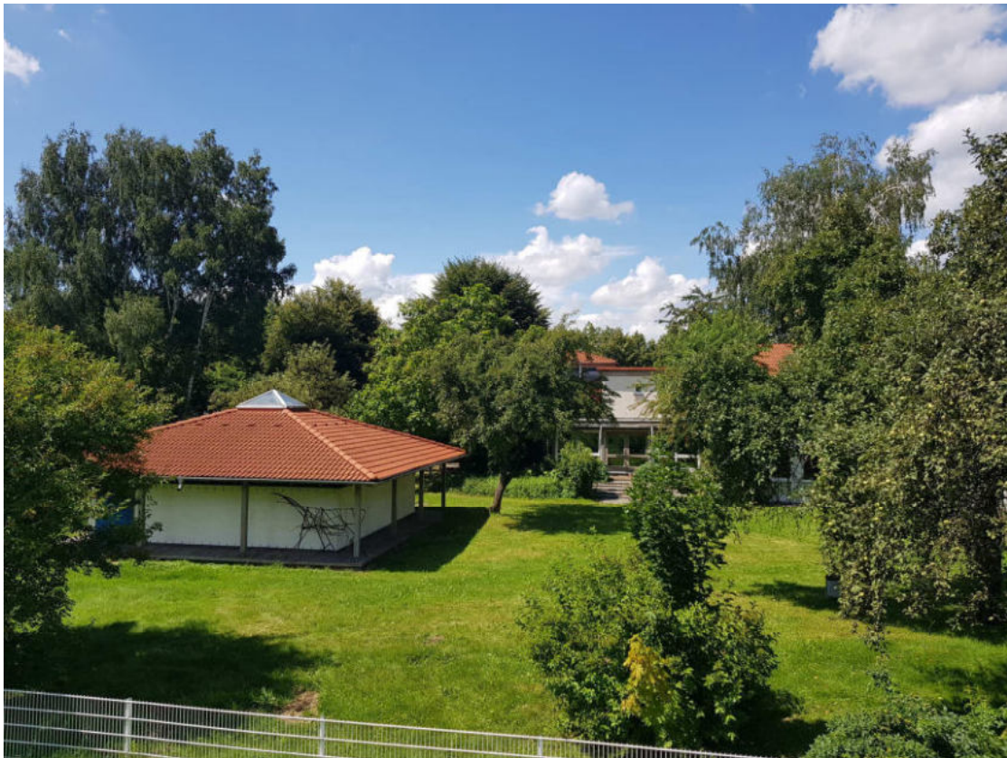
Fot. 2. Północna część obszaru opracowania od strony wału przeciwpowodziowego.
