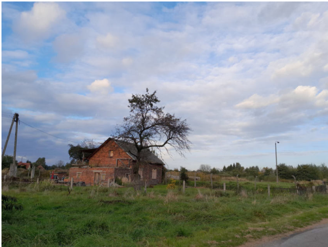
Fot. 1. Obszar opracowania – zabudowania położone w południowo-zachodniej części obszaru.
