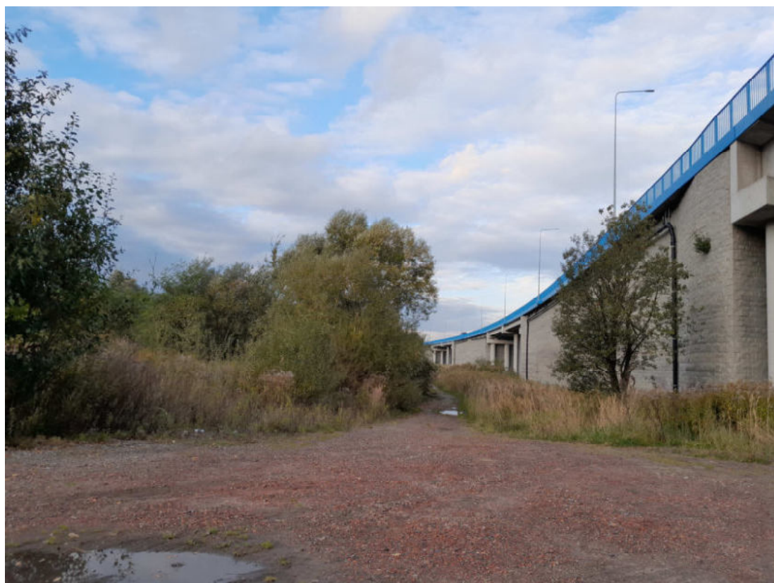
Fot. 4. Wschodnia część obszaru opracowania przy Obwodnicy Północnej – widok z ul. Wodociągowej w kierunku północnym.
