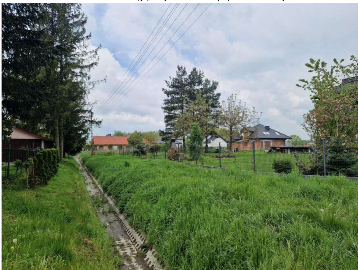
Fot. 8. Rów melioracyjny w rejonie zabudowań przy ul. Grabowieckiej.
