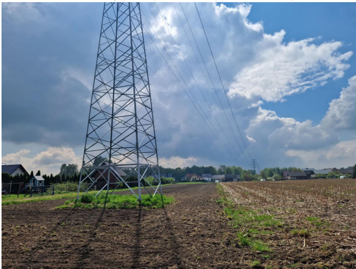
Fot. 1. Linia elektroenergetyczna w rejonie ul. Polowieckiej (widok w kierunku ul. Dąbrówki).
